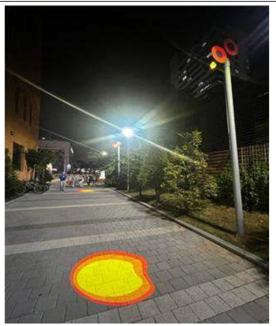
열주, 고보조명 설치 (후)
